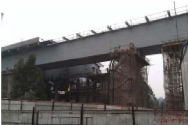
■顶推到位的桥梁
