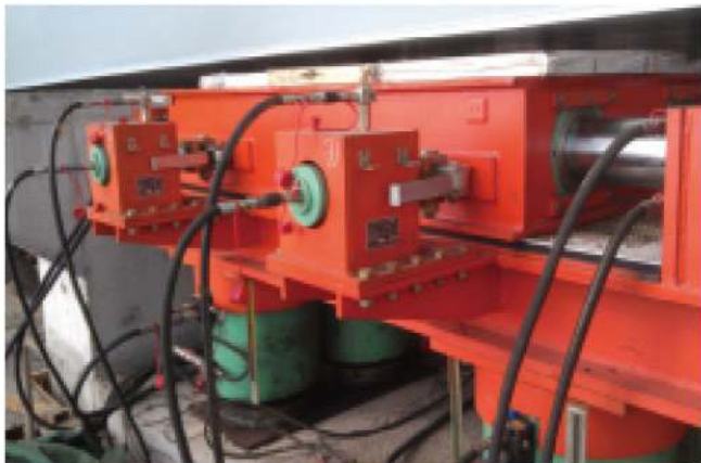
■施工中的步履式顶推装置
