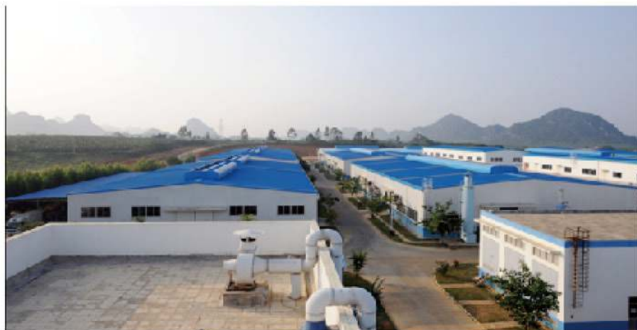
■广西田园生化股份有限公司的生产车间
